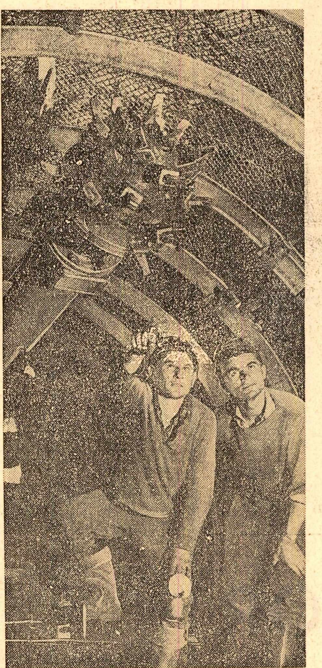
Galerii cu armare metalică la mina de cărbuni Horăști — întreprinderea minieră Motru. Șeful de schimb Constantin Botanciu și combinerul Mihai Lupșoiu clarifică o detașare de dirijare a minei de încălzire. Peste câteva secunde cuțitele ei vor tăia în plin
