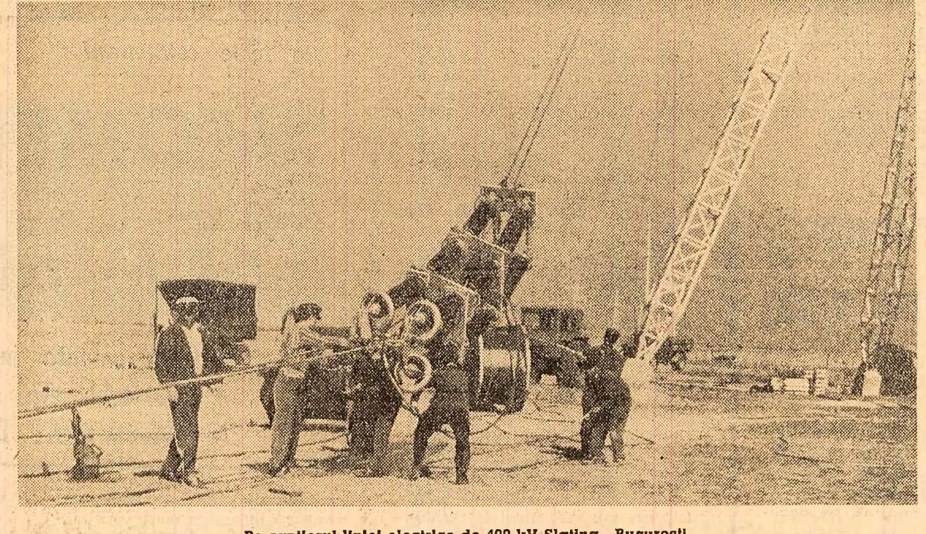
Pe șantierele liniei electrice de 400 kV Slatina—București
