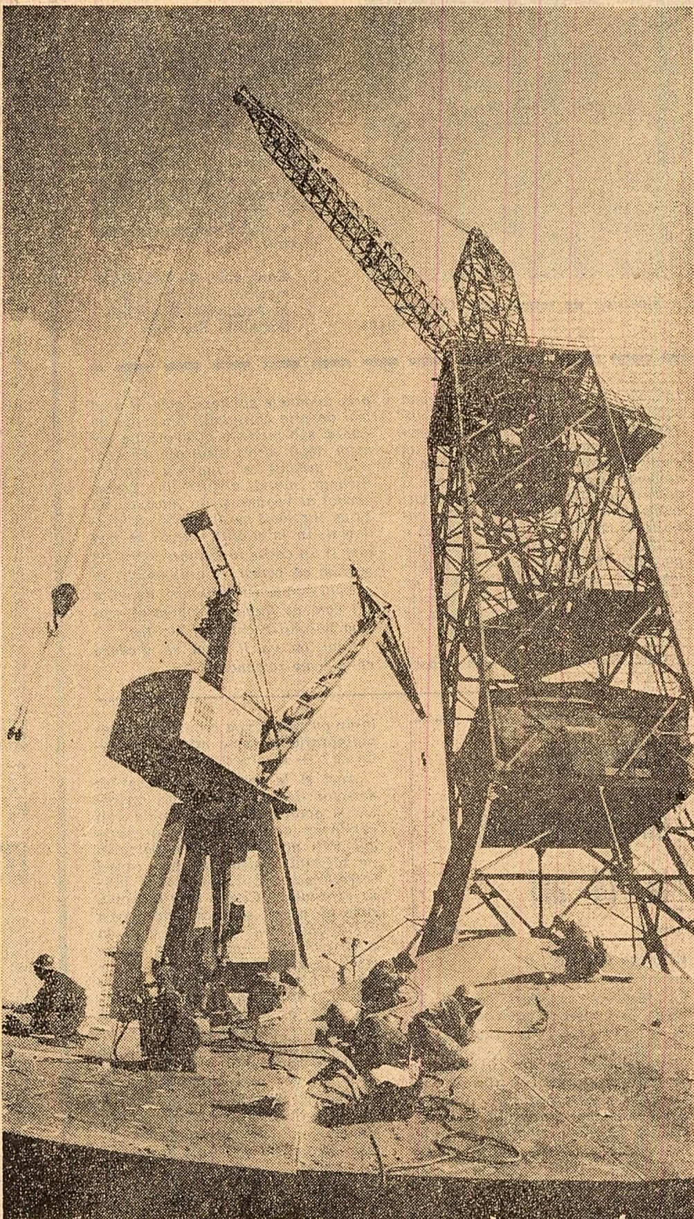
Șantierul naval Galați. Se asamblează secțiile unui vas mineralier de 12.000 tone. Foto: M. Andreescu
