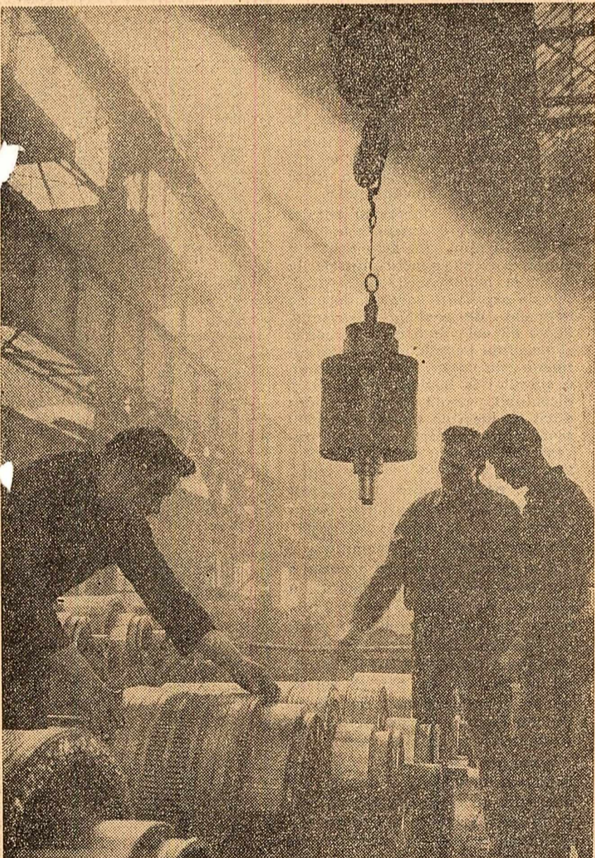
În secția mașinilor rotative de la uzina „Electroputere”-Craiova, lăcătușii montori Marin Bologan, Ion Petrescu și Constantin Dobrescu fac pregătiri pentru montarea unor motoare de tracțiune pentru locomotive Diesel electrice
