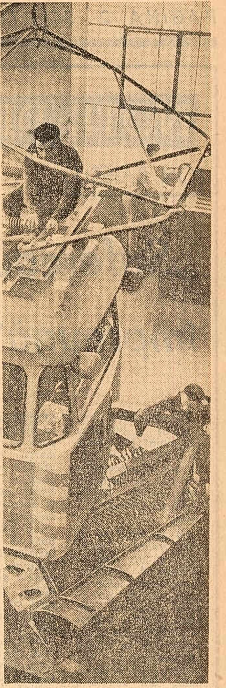
Atelierele centrale I.T.B. Special amenajate pentru dezvoltarea liniilor de tramvai, vagonul motor e gata. Se electuează acum un ultim control
