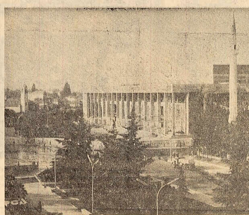
În centrul Tiranei (R. P. Albania) se construiește noul Palat al Culturii
