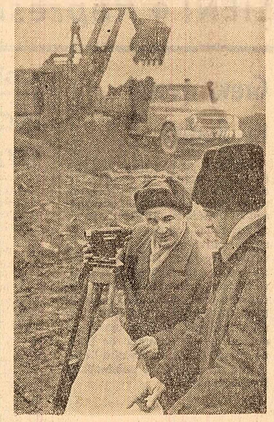
La uzina "Republica" din Capitală se execută lucrările de trasare ale noii sculării. Foto: M. Andreescu
