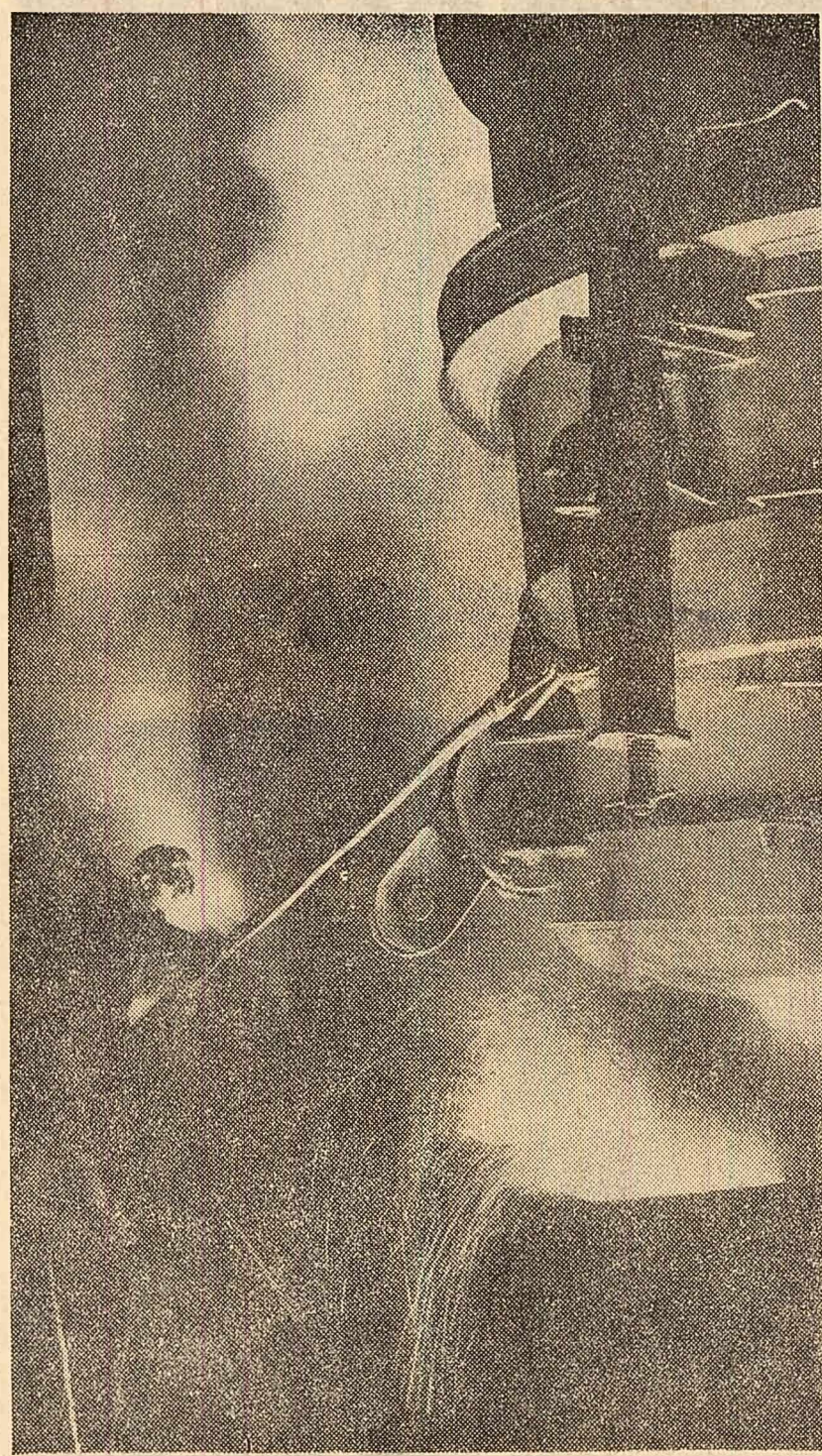
Oțelul proaspăt elaborat se toarnă în lingotiere. (Imagine cotidiană de la oțelăria Combinatului siderurgic Hunedoara)
