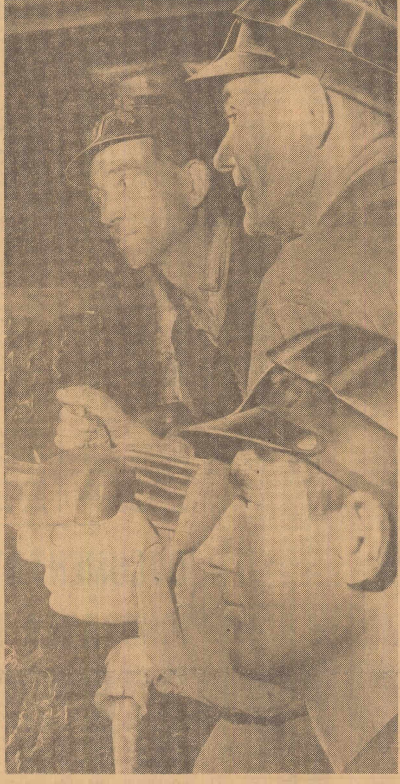
Exploatarea minieră Leorda II. Echipa formată din minierii Sebastian Stoian, Alexandru Petă și Ilie Tudose execută lucrări pregătitoare la unul din tronsoanele de lucru. Foto: M. Andreescu
