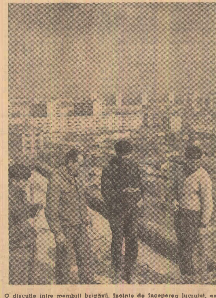
O discuție între membrii brigăzii, înainte de începerea lucrului, este foarte utilă (Pe șantierul III al Întreprinderii de construcții nr. 1 din Capitală) (Foto: Agerpres)
