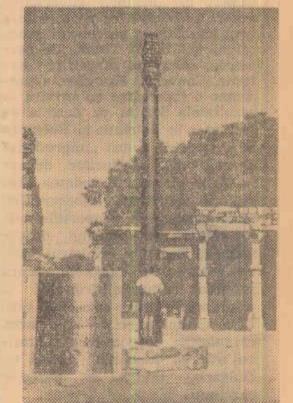
tă, nu a ruginit pînă azi. Fenomenul nu a putut fi încă clarificat definitiv. Se presupune că această particularitate se datorează aliajului din care este făcută coloana: 99,8% la sută fier, 0,114 la sută fosfor și 0,006 la sută sulf.
