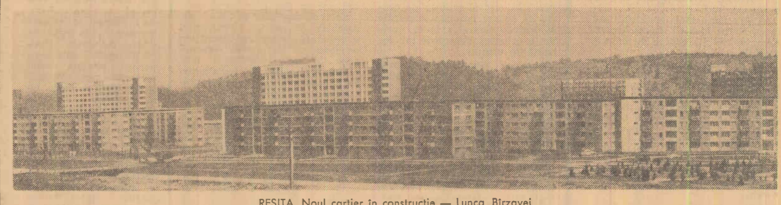
REȘIȚA. Noul cartier în construcție — Lunca Bîrzavei
