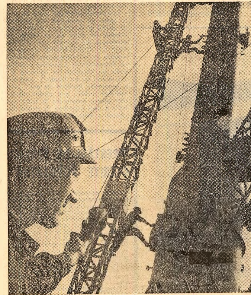
Pe șantierul Rafinăriei din Pitești Foto: M. Andreescu
