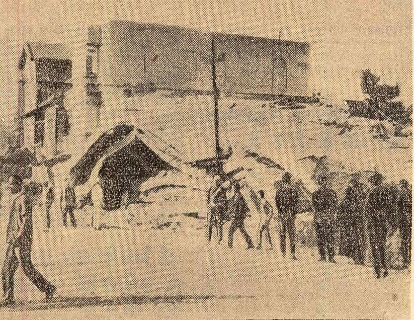
Clădire prăbușită în localitatea Adapazari
