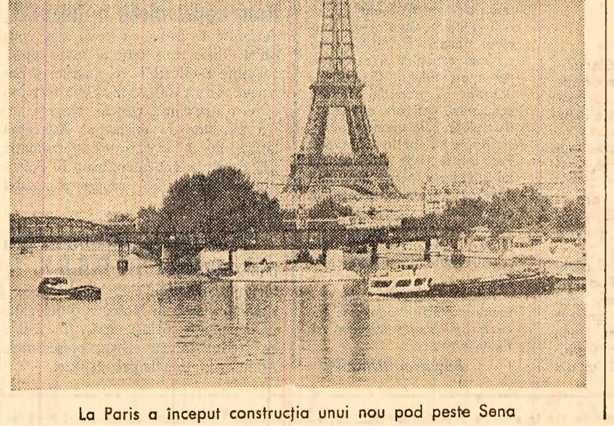
La Paris a început construcția unui nou pod peste Sena
