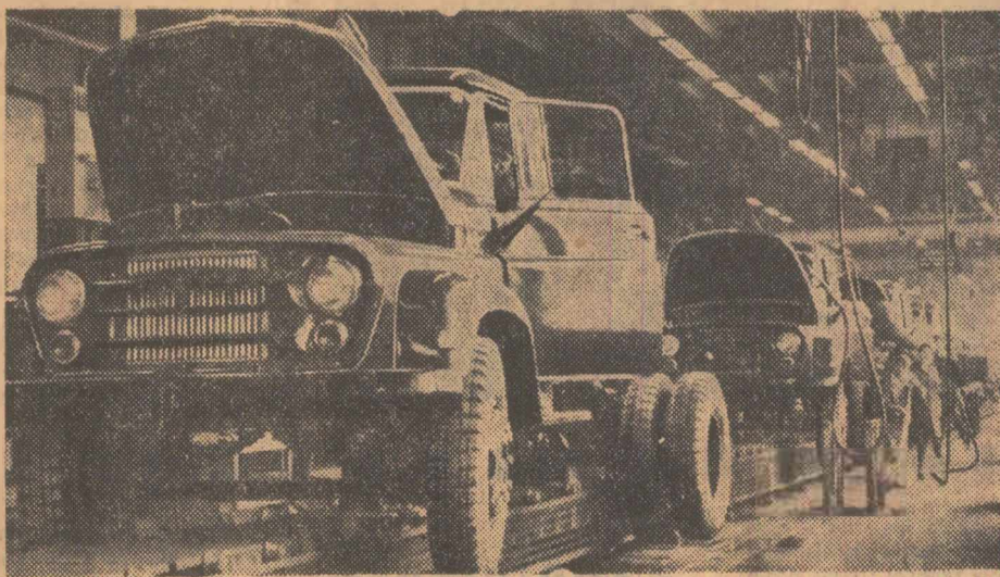
Pe banda de montaj general a Uzinei de autocamioane din Brașov Foto: Gh. Vințilă
