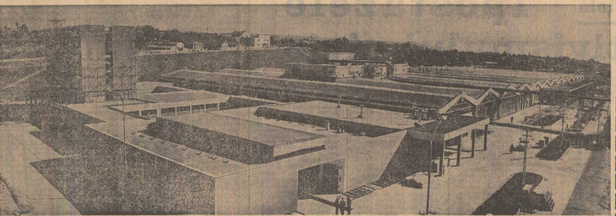
Pe pantierul noului Fabricii de mobilă din Vaslui
