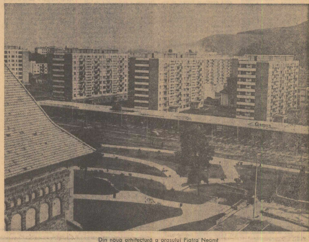
Din noua arhitectură a orașului Piatra Neamț
