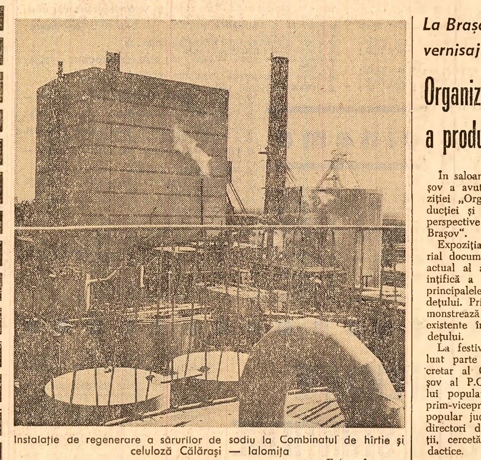
Instalație de regenerare a sărurilor de sodiu la Combinatul de hîrtie și celuloză Căldrăși — Ialomița Foto: Agerpres
