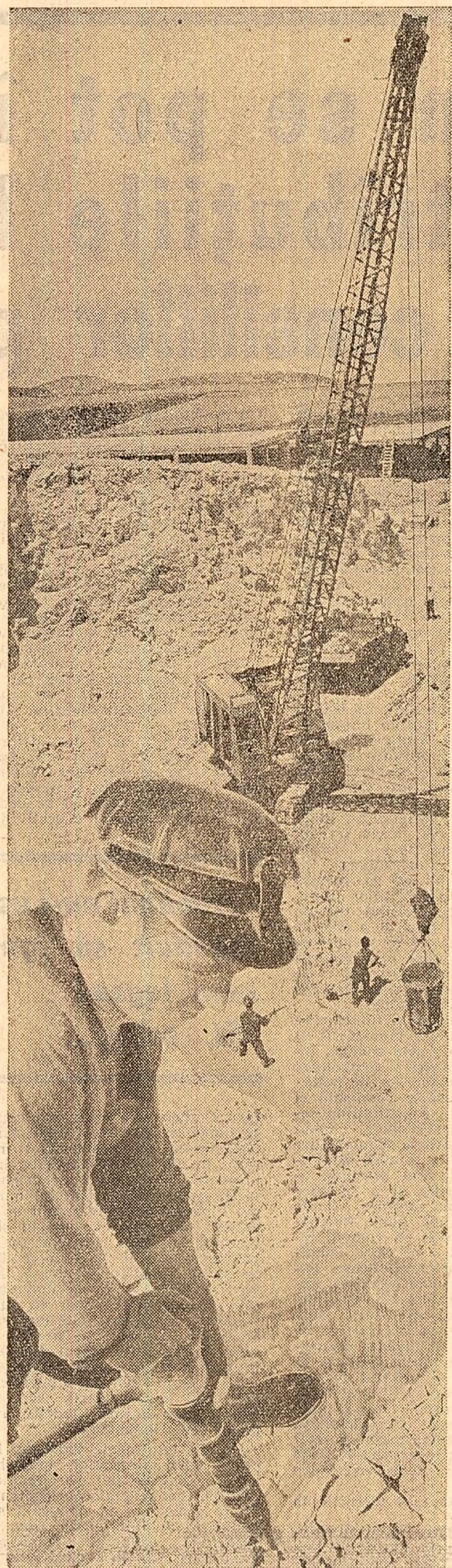
În peisajul tradițional din vecinătatea Mahmudiei și-au făcut apariția constructorii însoții de excavatoare, macarale, autobasculante și ciocane pneumatice...
