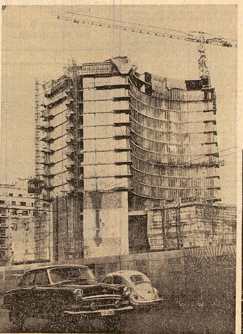
Șantierul hotelului „Intercontinental” Foto: Gh. Vințiu
