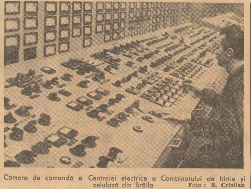
Camera de comandă a Centralei electrice a Combinatului de hirtie și celuloză din Brăila. Foto: S. Cristian
