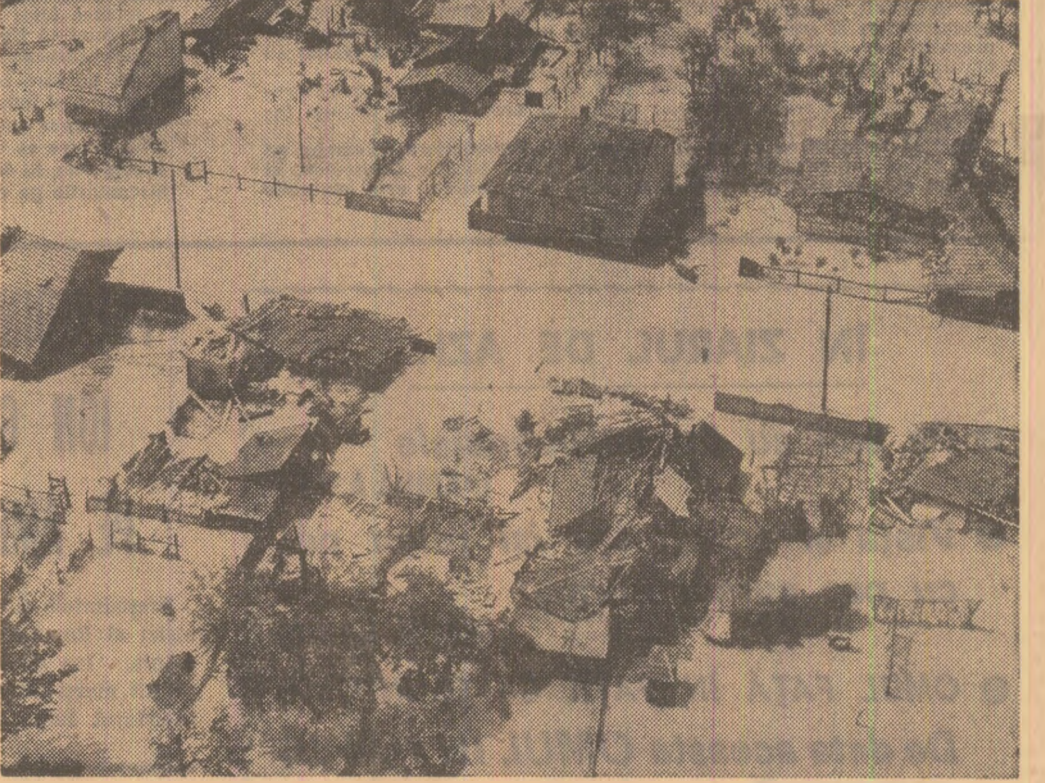
DE LA COMANDAMENTUL JUDEȚEAN CLUJ aflăm că în acest județ și-au pierdut viața 6 oameni. Conform evaluărilor făcute pînă ieri, pagubele materiale provocate de inundații se cifrează la 230 milioane lei. Din cele 2.669 locuințe inundate, majoritatea sînt avariate, iar 323 complet distruse. Au fost afectate de inundații 11 obiective economice și industriale, două școli generale, spitul și liceul din Dej. Fagure mari s-au produs în agricultura județului, fiind inundate aproape 20.000 hectare, din care 13.177 hectare teren arabil, 6.253 hectare pășuni și fînețe, 80 hectare cu vie, 75 hectare livezi. Culturile compromise cuprind peste 4.000 de hectare cultivate cu grâu și porumb, 695 hectare sfeclă de zahăr, 308 hectare cartofi, 428 hectare legume etc. DE LA COMANDAMENTUL JUDEȚULUI MARAMUREȘ se comunică o primă evaluare globală a victimelor omenești și pagubelor materiale provocate de calamități în cele 24 de localități inundate în cursul județului. Pînă în ziua de 19 mai s-au înregistrat 8 morți în localitățile Baia Mare, Sighetul Marmărei, Eorța și Cocirliu. Au fost distruse 786 case. Drumurile naționale au fost distruse și avariate pe aproape 30 de kilometri, iar cele locale pe 232 km. Rețeaua feroviară a fost distrusă pe o distanță de 25 km și avariată pe 53,5 km. Au fost scoase temporar din funcțiune 8 unități de producție, 6 dintre ele reluîndu-și pînă marți activitatea. DE LA COMANDAMENTUL JUDEȚULUI SĂLAJ aflăm că, potrivit unei prime evaluări, peste 200 de case sînt complet distruse, iar alte 200 sînt afectate parțial. În total au fost evacuate din zona revărsării apei 2.086 de familii. Din 29 de poduri distruse au fost refăcute 9, iar din 435 podețe avariate s-au refăcut pînă în prezent 208. În acest județ au fost afectate de inundații 16 km de linii electrice, 19 km linii telefonice, 187 km de șosele, 20 km de cale ferată. Cea mai mare parte a rețelelor de transport și telecomunicații a fost repusă în funcțiune.
