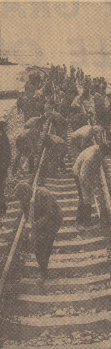
Lucrări de refacere a liniei ferate Galați — Brăila distrusă de inundații
