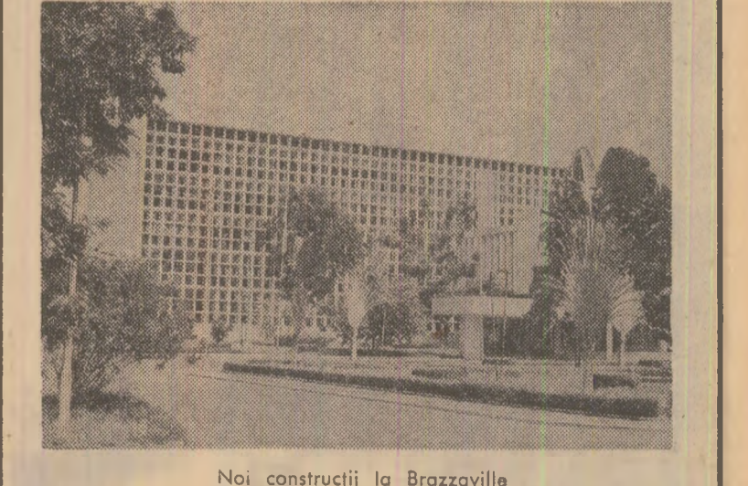
Noi construcții la Brazzaville
