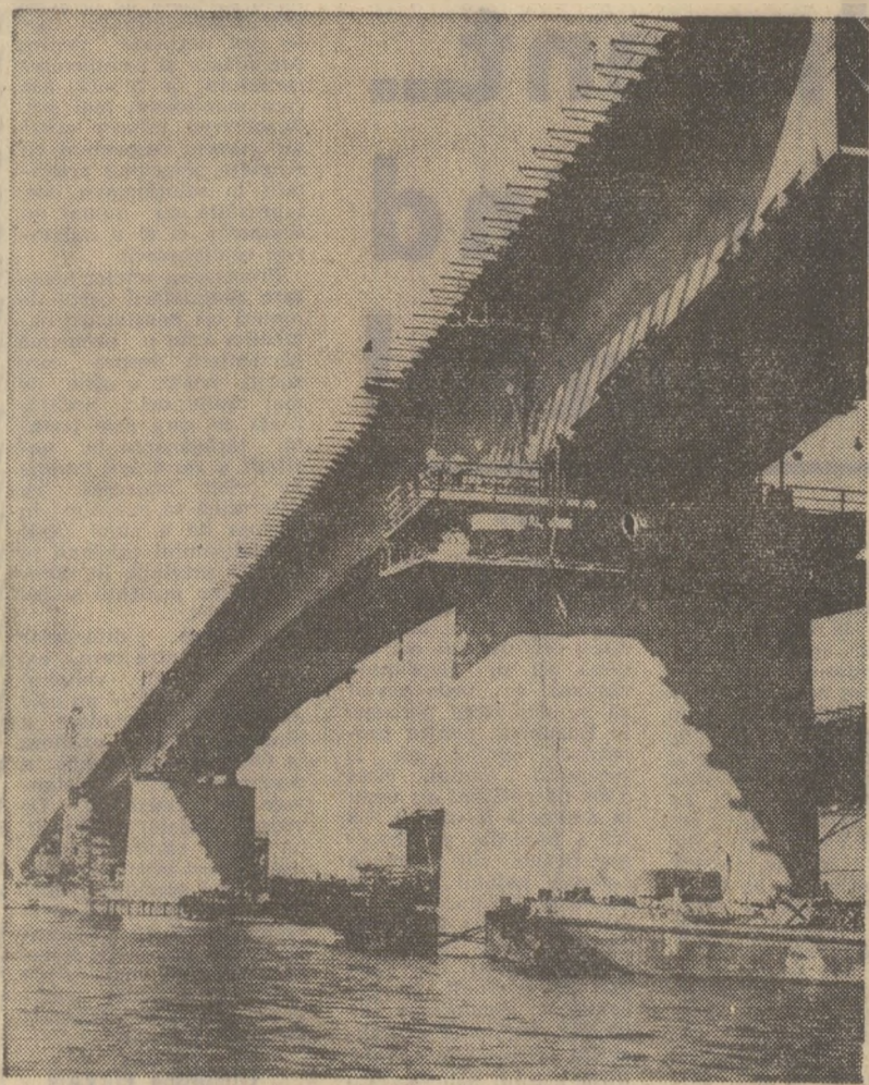
În aceste zile, construcția podului rutier de peste Dunare, de la Giurgeni — Vadul Oii, a intrat în etapa sa finală. Prin lansarea pe apă și așezarea, cu succes, pe piloni săi de susținere a celui de-al treilea tronson metallic al arcului transdunubian, s-a creat posibilitatea certă ca marea punte de oțel dintre țărmurile muntene și dobrogene să fie dată în circulație până la sfârșitul anului.
