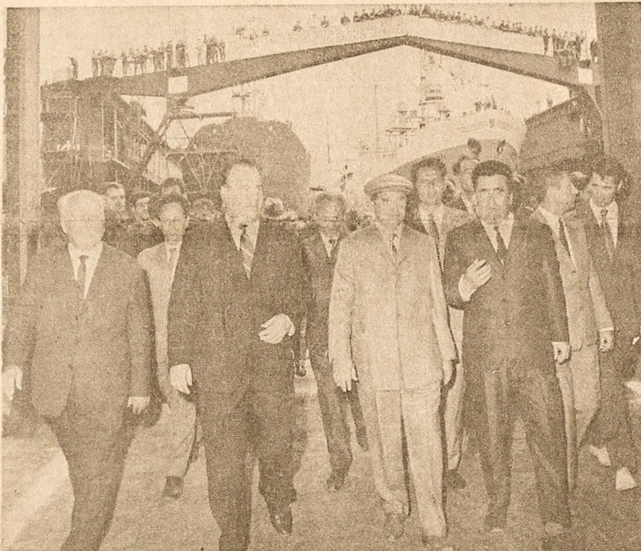
Pe șantierul de construcții navale din Constanța.
