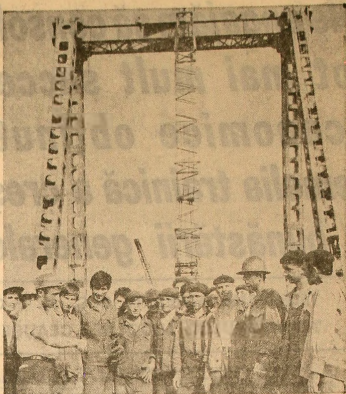
Construcții pe șantierul uneiia dintre cele mai moderne vetre ale oțelurilor de fabricație românească
