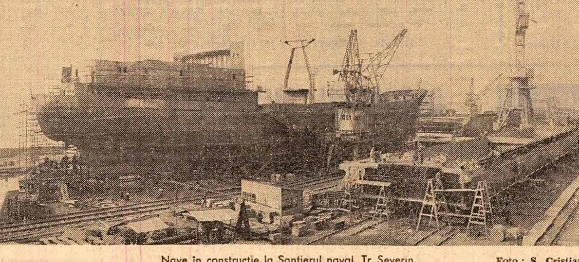
Novă în construcție la Șantierea naval Tr. Severin Foto : S. Cristian
