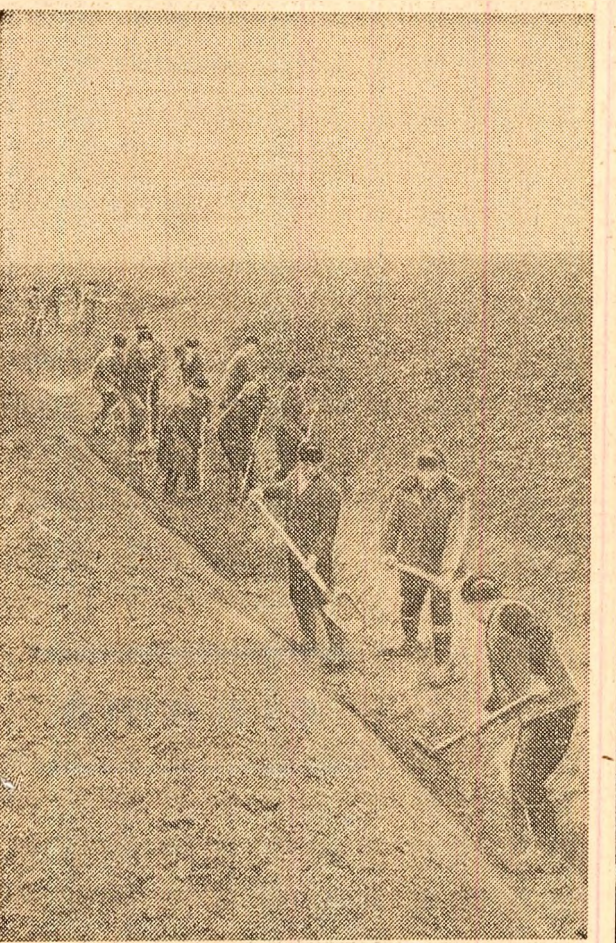
La cooperativa agricolă din Jirlău, județul Brăila, se lucrează intens la executarea canalelor pentru scurgerea excesului de apă.
