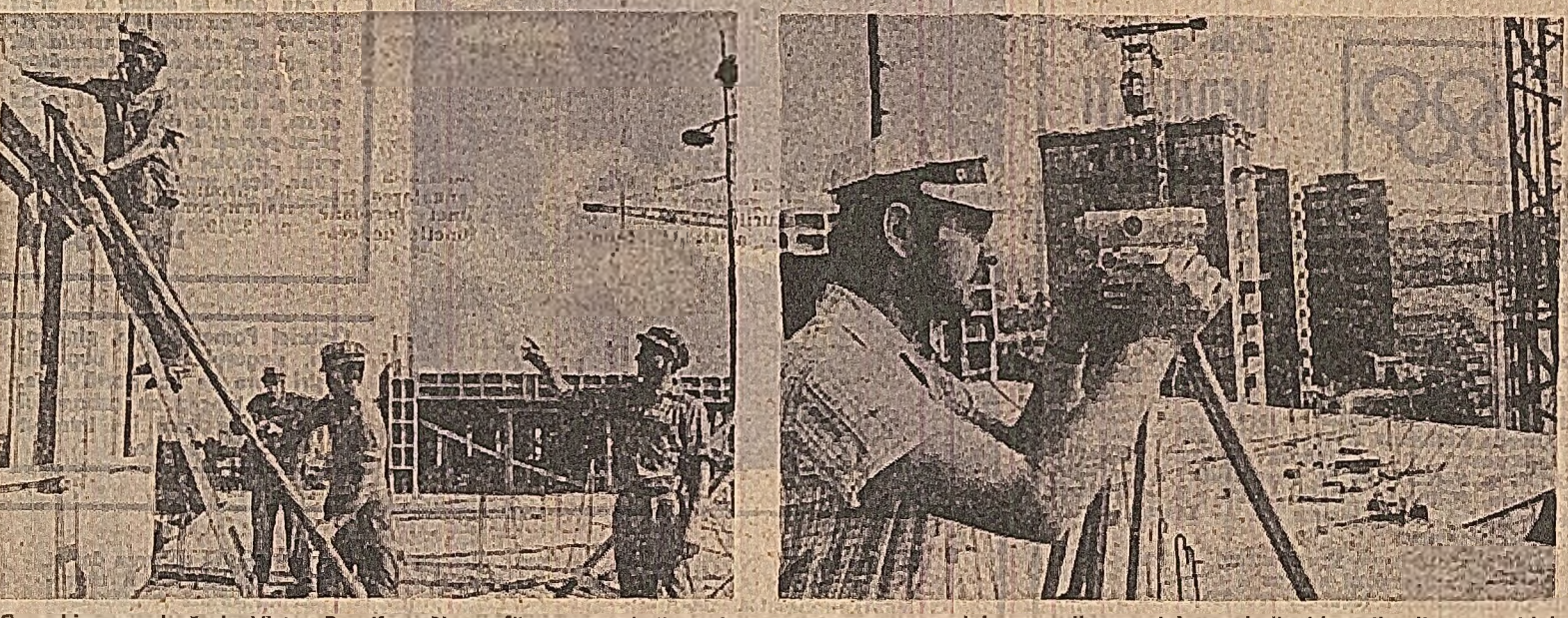
Cu echipa condusă de Victor Rus (foto 1) am făcut cunoștință în timp ce executa montajul panourilor mari la unul din blocurile din ansamblul de locuințe „Alexandru cel Bun” din Iași. Obiectivele esențiale ale lucrărilor sînt reduse, rapide, în imaginea cea de față (foto 2), ing. T. Traian controlează calitatea lucrărilor. Calificativul? — „Foarte bine”. Foto: M. Andreescu
