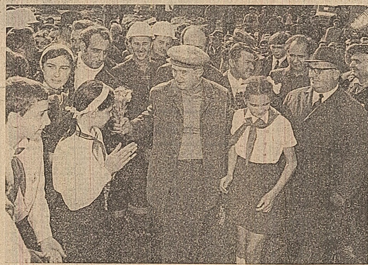
Pe șantierul uzinei de vagoane
