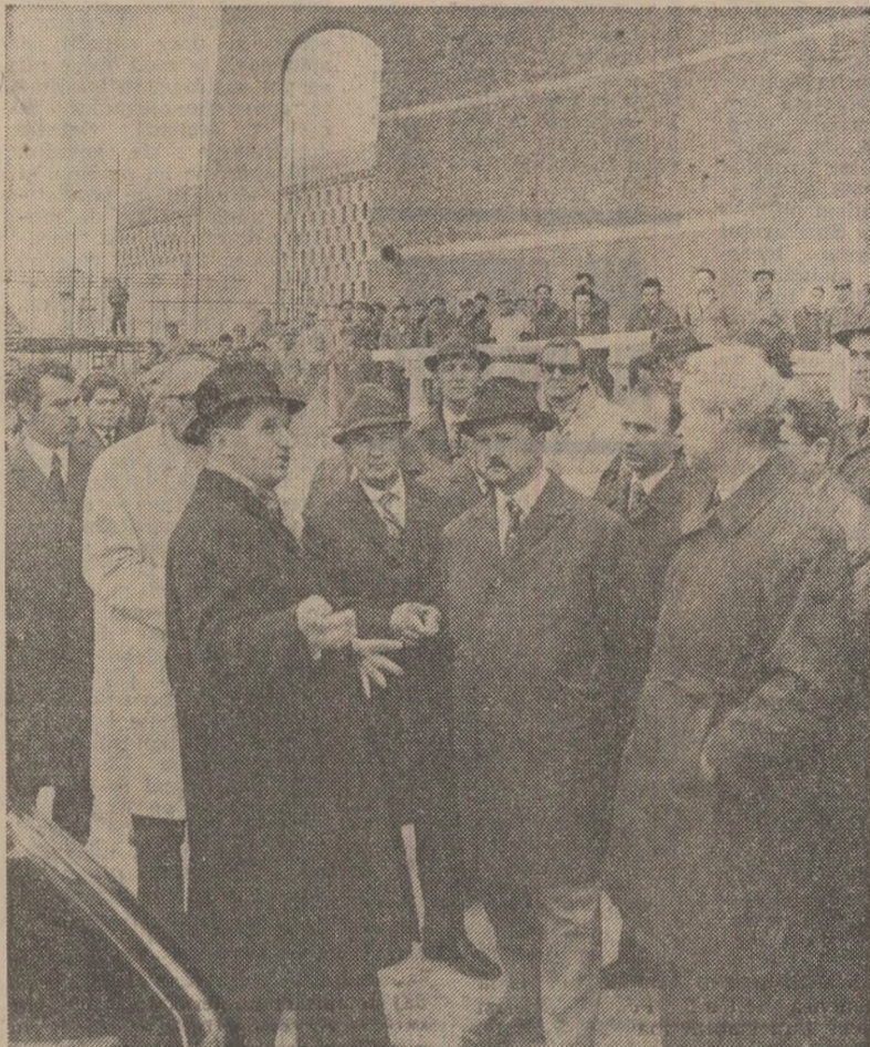
Santierul Teatrului Național: Acest edificiu trebuie să fie la înălțimea menirii sale!
