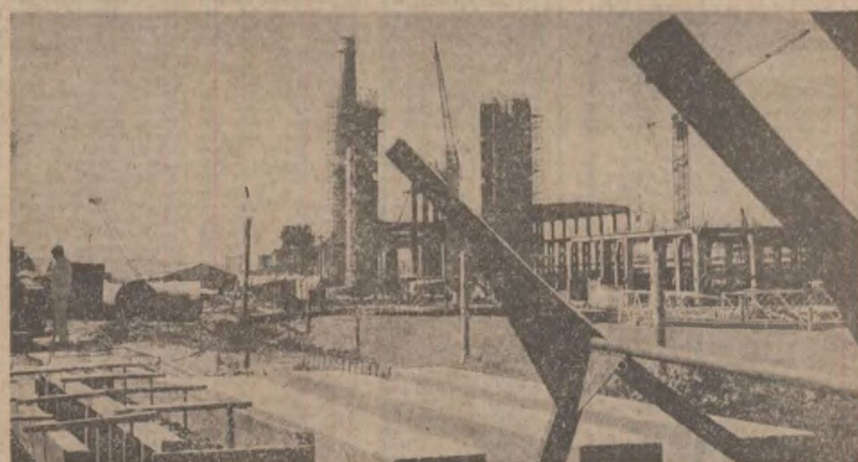
Imagine de pe șantierul Uzinei de aluminiu din Tulcea
