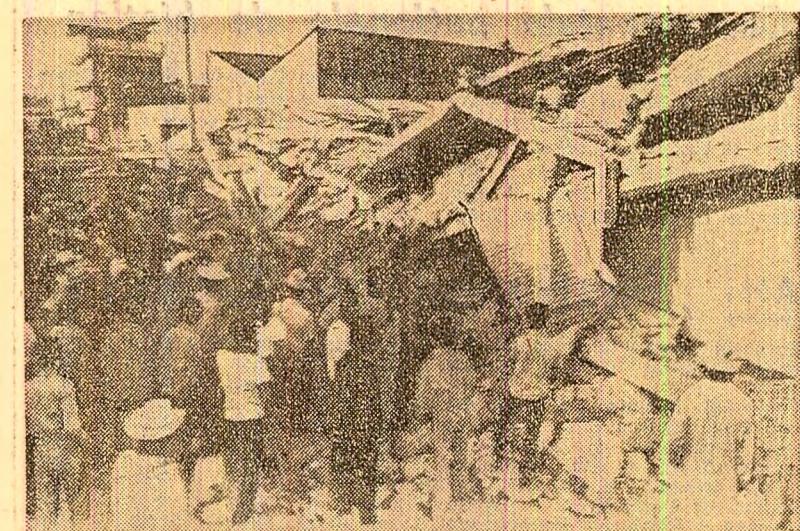
În timpul cutremurului de la Tecoman, localitate din Mexic, situată în apropierea coastei Pacificului, au fost distruse mai multe clădiri, iar 15 persoane și-au pierdut viața
