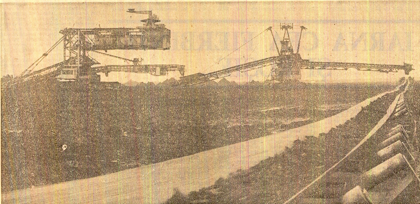
BAZINUL CARBONIFER ROVINARI, CARIERA CICANI. Utilajele moderne, de mare randament - deservite de muncitori cu înaltă calificare - funcționează neîntrerupt, pentru a da economiei cantități tot mai mari de cărbune
