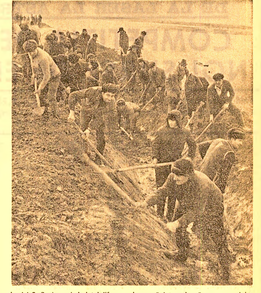
La I.A.S. Buciumeni, județul Ilfov, se lucrează intens la săporea canalelor pentru desecarea terenurilor din lunca Argeșului
