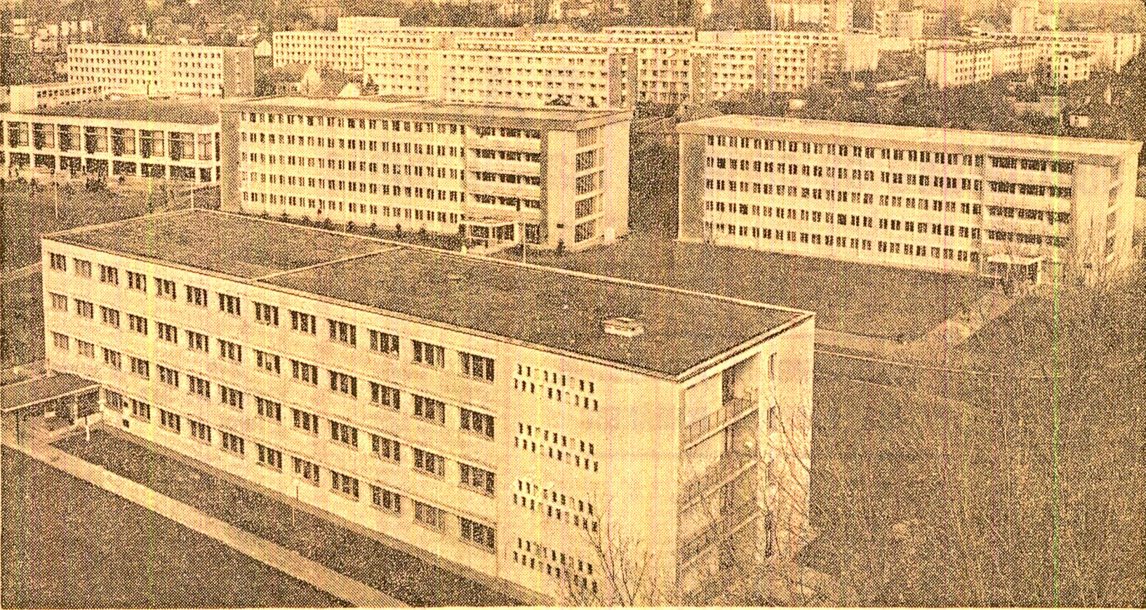
Din noua arhitectură a orașului Timișoara
