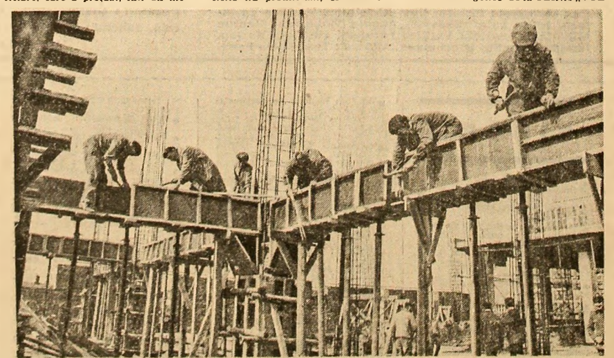
Pe șantierul Uzinei de mecanică fină din București se dă o aprigă „luptă” cu timpul pentru scurtarea termenului de punere în funcțiune a noului capacitate de producție ce se construiește aici. Dulgherii din formația lui Anghel Constantin (în fotografie) se situează, prin rezultatele obținute zilnic, în primele rînduri
