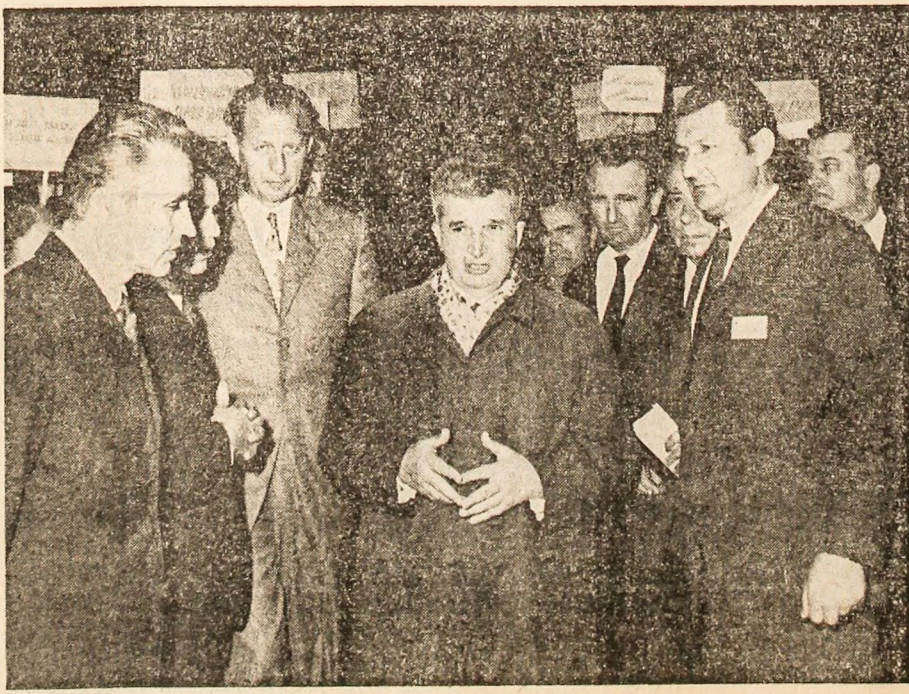
Pe șantierul Întreprinderii de mașini-unelte, recomandări pentru intrarea neîntîrziată în funcțiune
