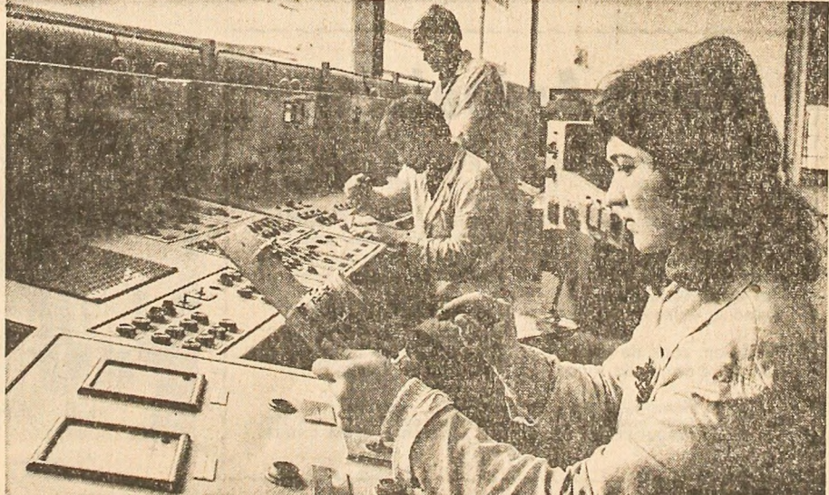
Fabrica de panouri și tablouri electrice din Alexandria completează peisajul industrial în plină dezvoltare al acestui oraș. Aici se produce o mare diversitate de panouri, pupitre de comandă și tablouri de automatizări pentru mașini-unelte
