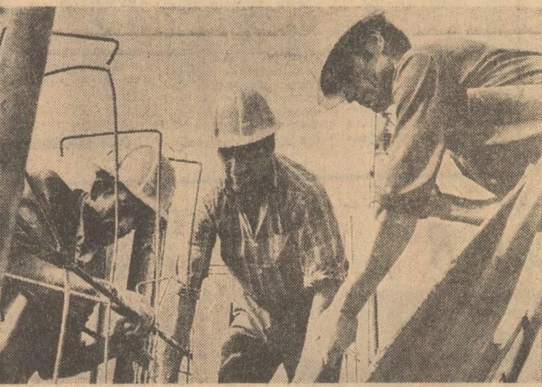
Hotărâți să-și realizeze în bune condiții sarcinile ce le revin în luna septembrie, constructorii de pe șantierul Combinatului chimic Turnu-Măgurele (în fotografie) obțin zilnic ritmuri superioare de lucru
