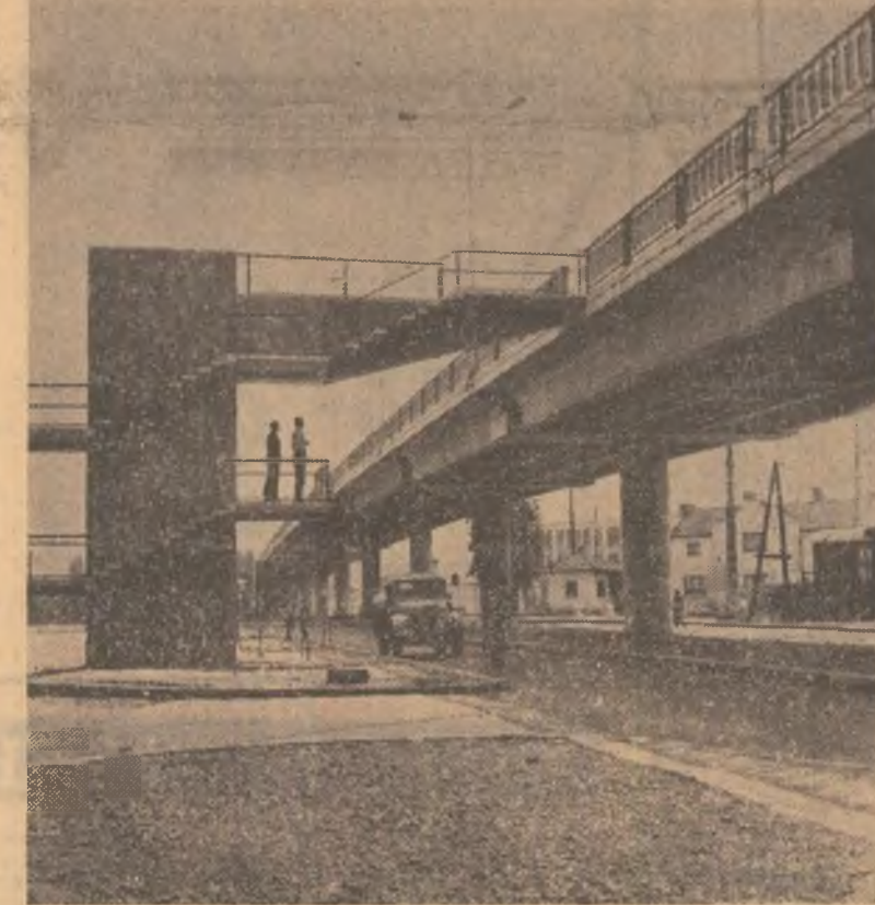
Perforarea îmbunătățirea circulației la Suceava a fost dot de curînd în funcțiune noou viaduct Foto: E. Dichiseanu
