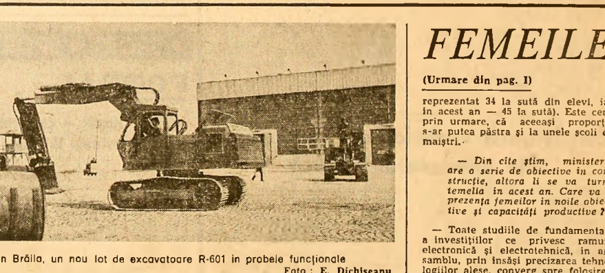
La întreprinderea „Progresul” din Brăila, un nou lot de excavatoare R-601 în probele funcționale
