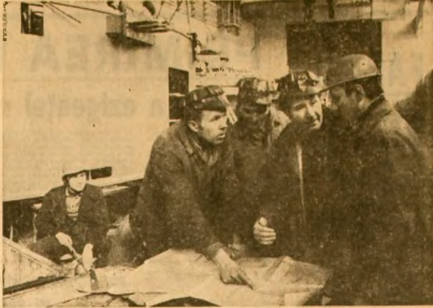
Pe șantierul hidrocentralei de la Rimnicu-Vilcea — analiză temeinică, schimb de soluții la montajul unui nou agregat. Foto: M. Andreescu
