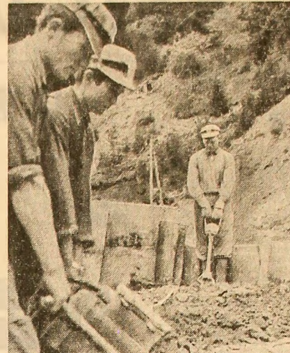
Se toarnă încă o lamelă în barajul de la Petrimanu-Lotru
