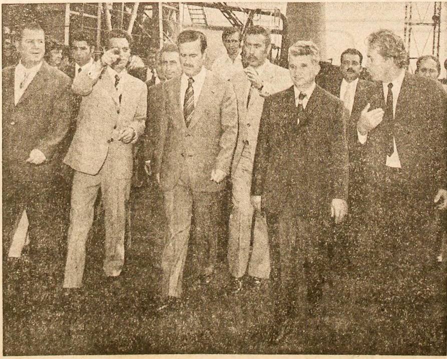
Aici, la „1 Mai”, unde se realizează instalațiile de țară, cunoscute în întreaga lume
