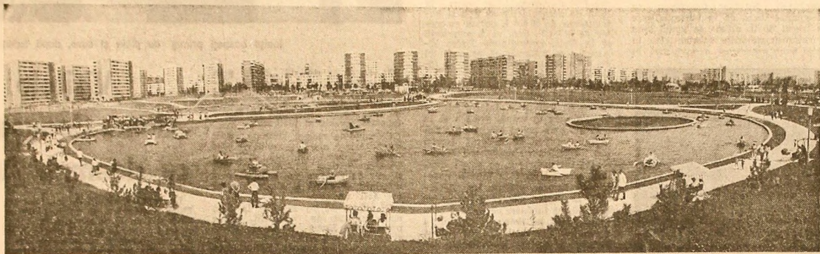
Cartierul Drumul Taberei — unul din marile ansambluri urbanistice ale Capitalei — și-a sporit recent zestrea de frumusețe prin darea în folosință a parcului de odihnă și agrement. Construit prin munca entuziasată a miilor de cetățeni, elevi și tineri din cartier, el oferă multiple posibilități pentru odihnă, pentru practicarea sporturilor — datorită dotărilor de care dispune: un mare lac, terenuri de sport, jocuri mecanice și distractive, altele de promenadă etc. Foto: S. Cristian
