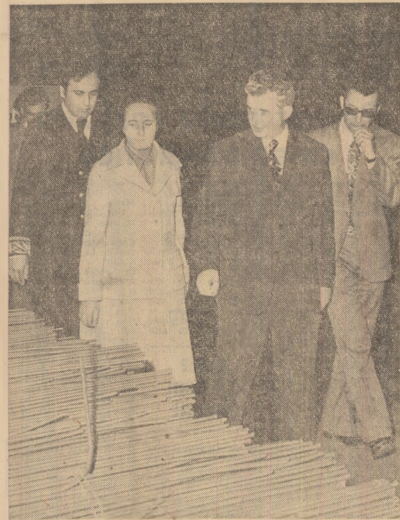
Se vizitează laminorul de la complexul siderurgic „El Fouladh”
