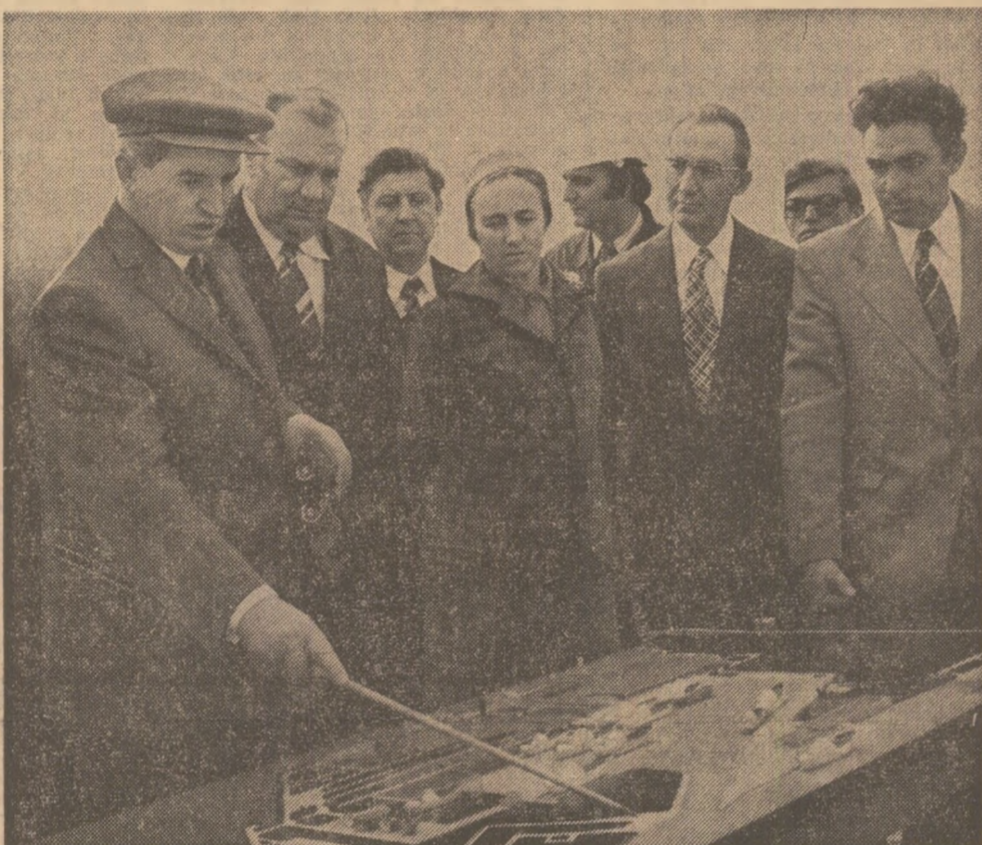
În fața machetei viitorului șantier naval
