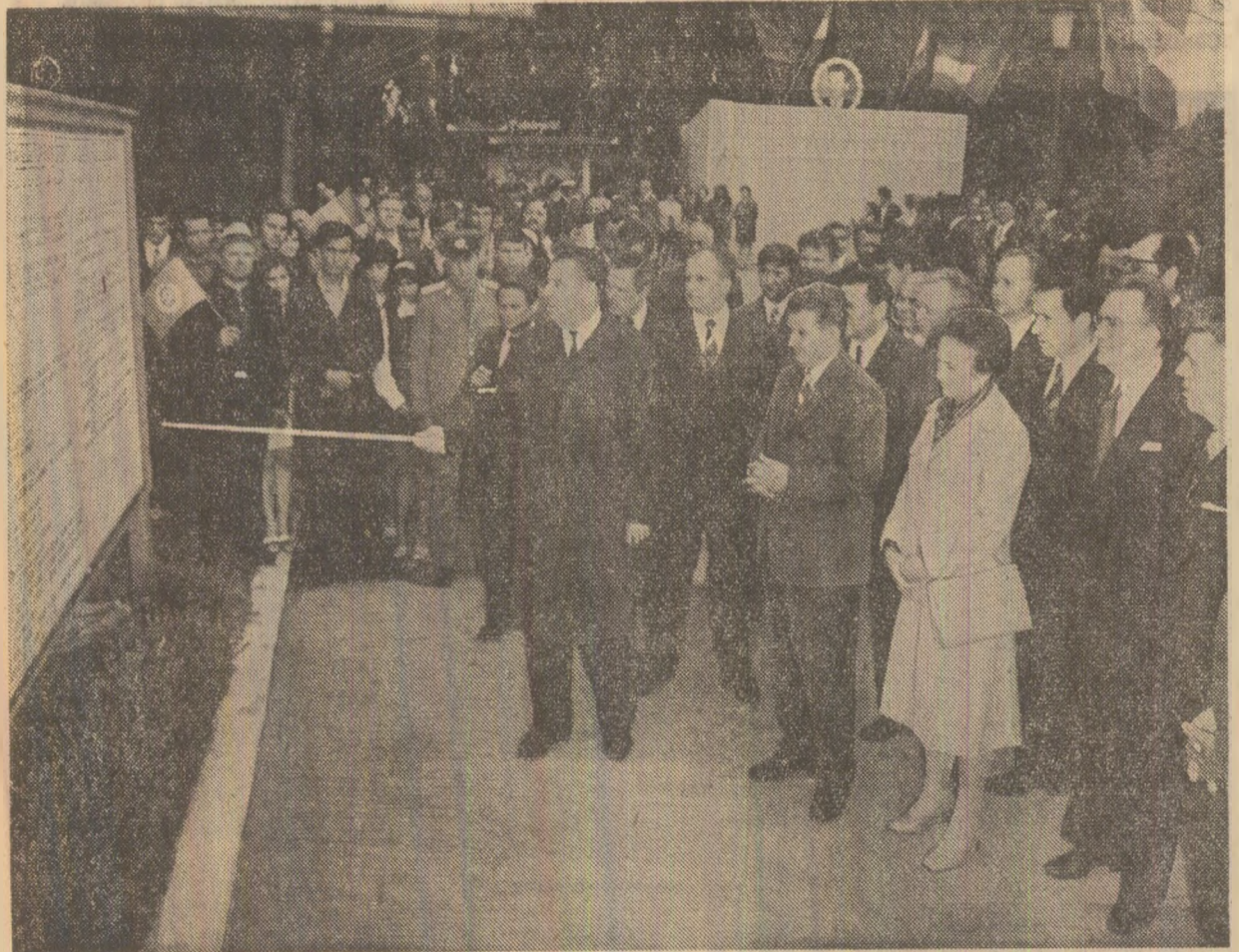
La întreprinderea metalurgică Aiud
