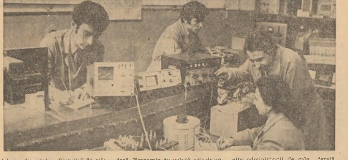
Telescopul și echipamentul de măsură și verificare a funcționării sistemului de automatizare a circulației trenurilor pe calea ferată.
